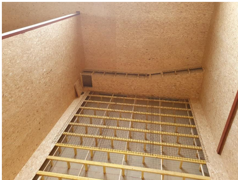
Figure 38 : Photo d'une cellule de séchage de fourrage vrac avant la première utilisation. Caillebotis en treillis métallique posé sur des structures en sapin (Source : AS DEV.)
