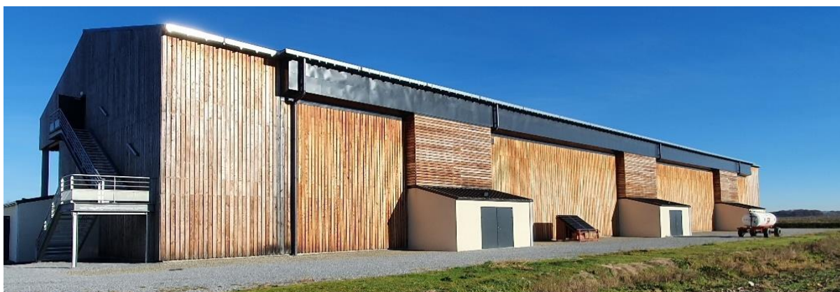
Figure 31 : Photographie d'une plateforme de séchage et conditionnement de fourrage dans les Pyrénées-Atlantiques - Capacité : 1300 tonnes par an (Source : AS DEV.)
